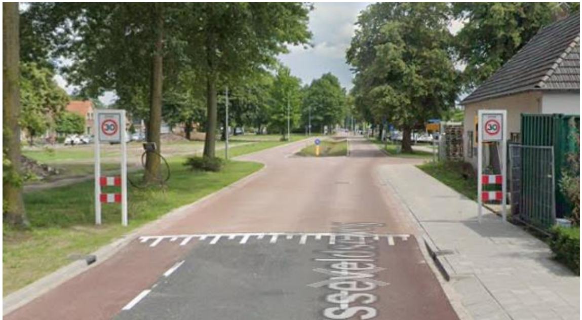
In Lichtenvoorde (Gelderland) is de 30-weg bij een basisschool veranderd in twee van elkaar gescheiden banen. Net breed genoeg voor één auto. Automobilisten moeten dus achter de fietsers blijven rijden. Dit zorgt in dit Gelderse dorp voor verkeersveiligheid in de buurt van een basisschool.
